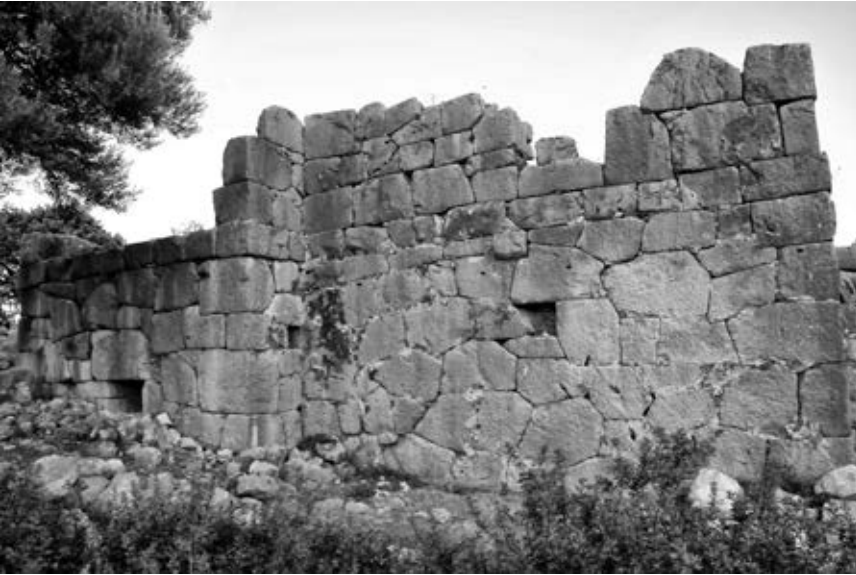
Res. 10 Doğu cephe ve konsollar
